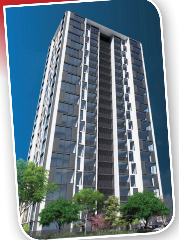
BB Yapı \ Çınar Apartmanı
